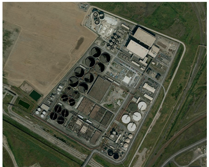
Obrázek 1: Čistírna odpadních vod Bran Sands
