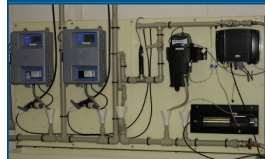
Obr. 3 Panel před akumulací pitné vody
