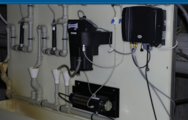
Obr. 2 Panel za pískovými filtry
